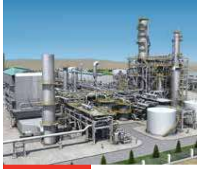
Gara Boğaz Gübre Fabrikası Türkmenistan
